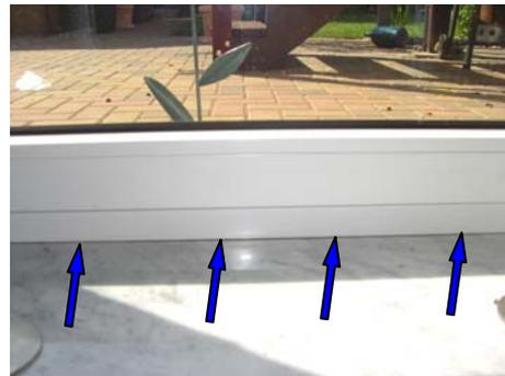
Undichtigkeiten am Anschluss des Fensterrahmens an die Fensterbank
