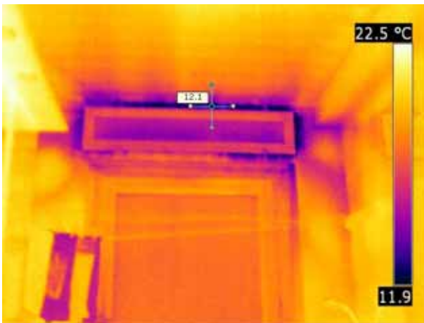
Deckel des Jalousiekastens sehr undicht
