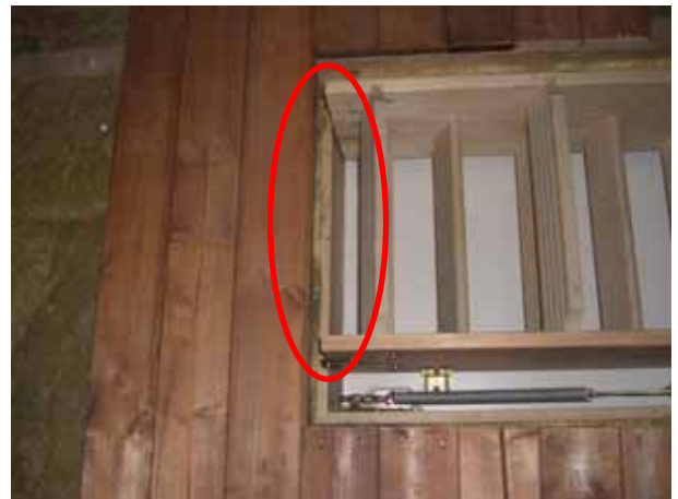
Dachbodenluke von oben: Undichte Schließung an den Scharnieren
