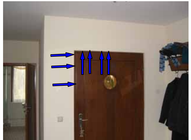
Hauseingangstür: Undichte Schließung oben links (hohe Undichtigkeit)
