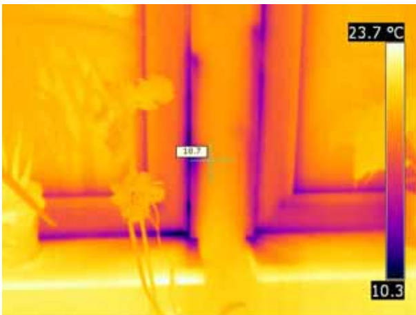
Anschluss des Fensterrahmens an Wandkonstruktion undicht
