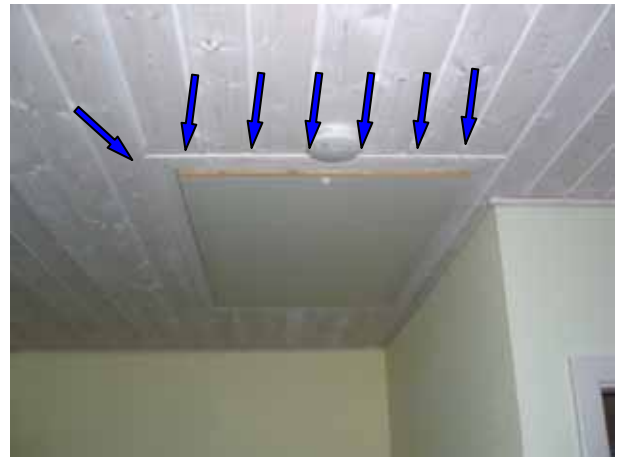
Dachbodenluke mit großen Undichtigkeiten – Fehlkonstruktion!
