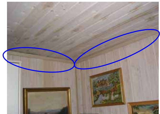
Deckenverkleidung und Anschlüsse der Decke an die Wand sehr undicht
