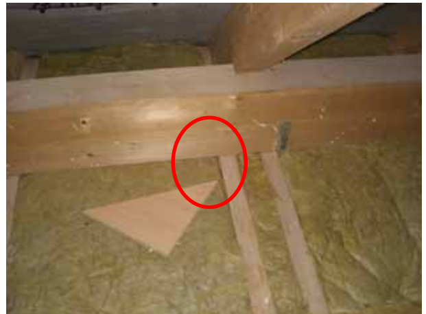
Dachboden: Dämmung undicht – erwärmte Raumlufte aus dem OG strömt ein. Sparrenfeld Dachbodenluke links linke Seite
