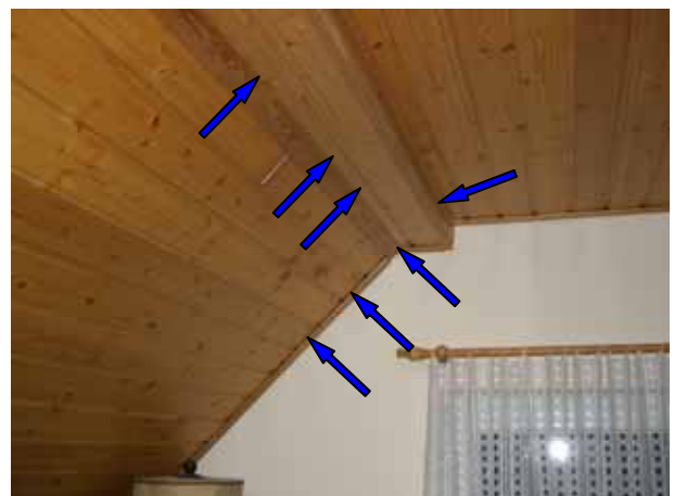
undichte Holzverkleidung (Holzbalkenverkleidung, Wandanschluss)
