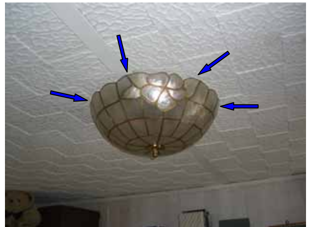
Zuführungskabel durchstößt Deckenverkleidung und verursacht Undichtigkeit
