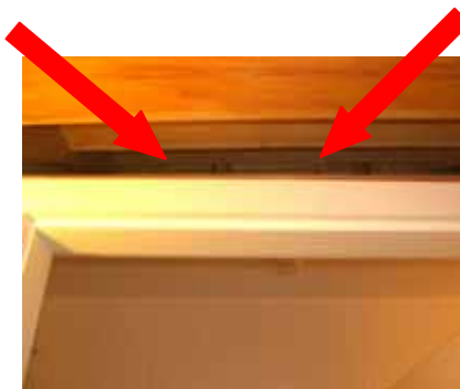
Hohlraum über der Kellertreppentür (vom Keller aus gesehen)
