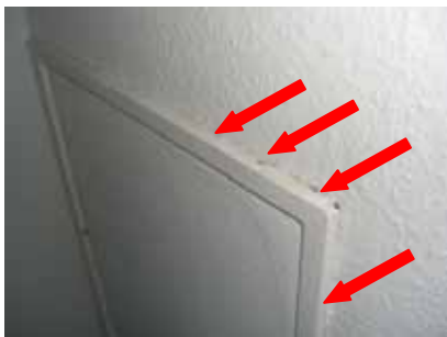
Abseitentür gegenüber Treppenaufgang 1. OG
