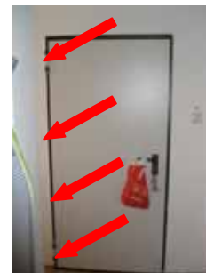
Tür im Keller zur Garage
