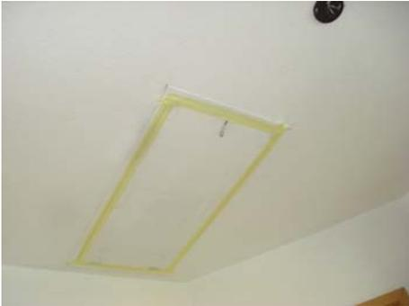
Dachbodenluke ist undicht – hier abgeklebt
