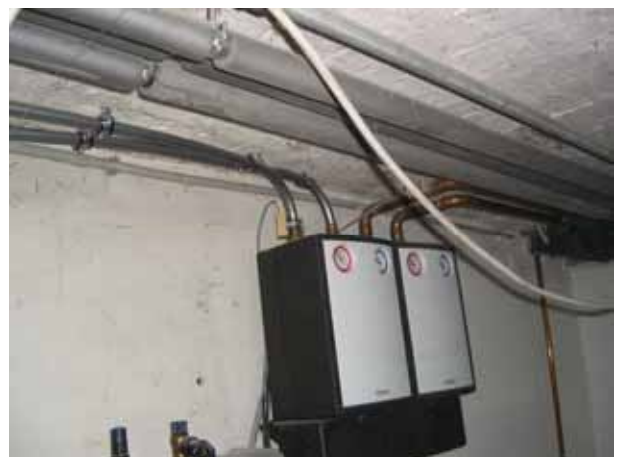
Ungedämmte Verteilleitungen für Heizung im Keller – hohe Wärmeverluste
