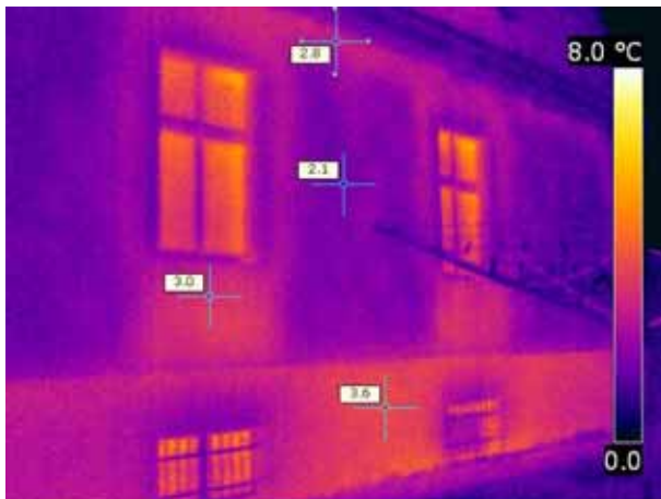
Hohlmauerwerk mit Kerndämmung, unter den Fenstern ist kein hohles Mauerwerk
