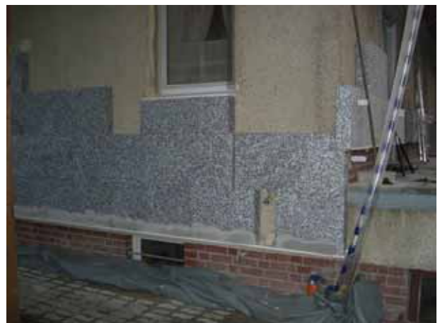
Vergleich gedämmt – ungedämmt. Aufnahme ist während der Dämmarbeiten am frühen Morgen entstanden
