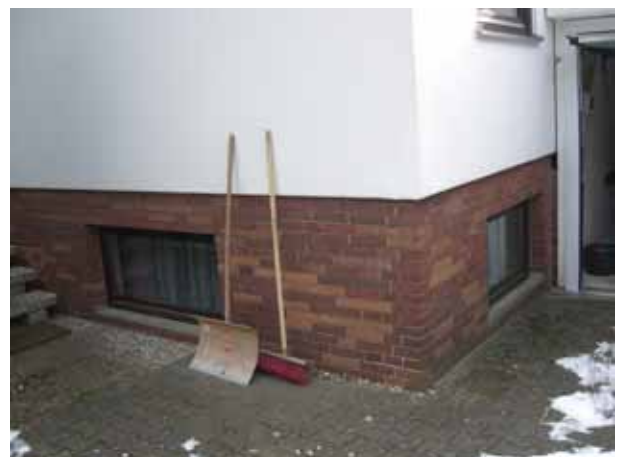
Wärmeverluste über Kellerfenster und Sockelmauerwerk
