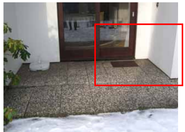
Wärmeverluste über undichten Wandanschluss bei einem Fertighaus
