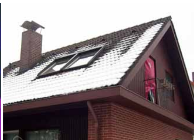
Wärmeverluste über undichtes Dach und undichten Einbau der Dachfenster
