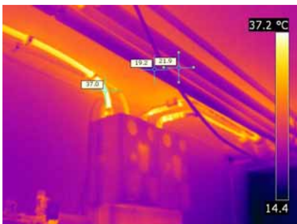
Ungedämmte Verteilleitungen für Heizung im Keller – hohe Wärmeverluste
